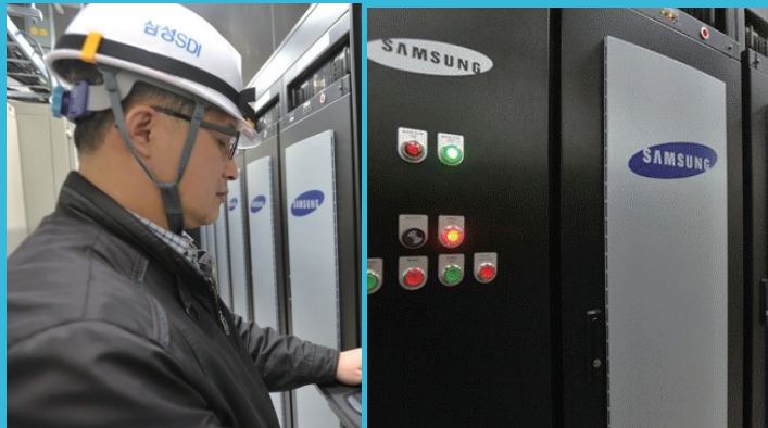
삼성SDI 의왕사업장에 설치된 UES
