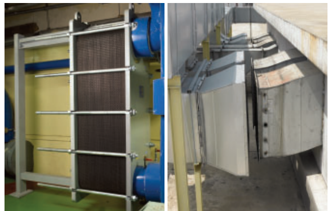
에너지 절감 사례 : 열 교환기(부산)와 폐열 재활용 설비(천안)
