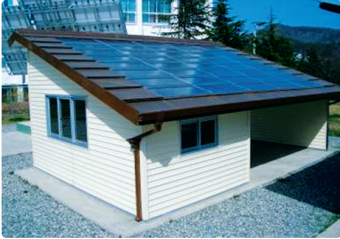
국내 최초 국산 다결정 Si PV House: 3KW급 PV 시스템
